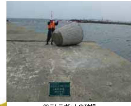
③テラポットの破損
