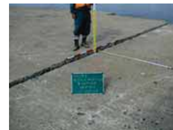
図 3-2 調査概要【西防波堤(第一)】
