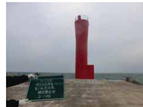
③灯台が設置されているケーソンの上部工は過去に補修されていたため、被害が少ない。
