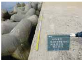
①テトラポットとの摩擦による上部工の欠損
