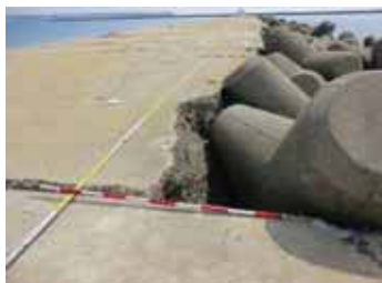
②テトラポットとの衝突による上部工の破損
